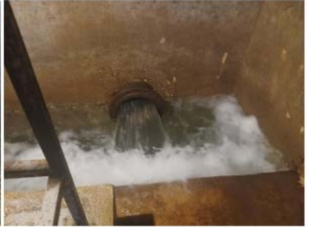
Slika 9 – Objekat sabirne komore i hlorna stanica i Slika 10 – Dotok vode u sabirnu komoru
