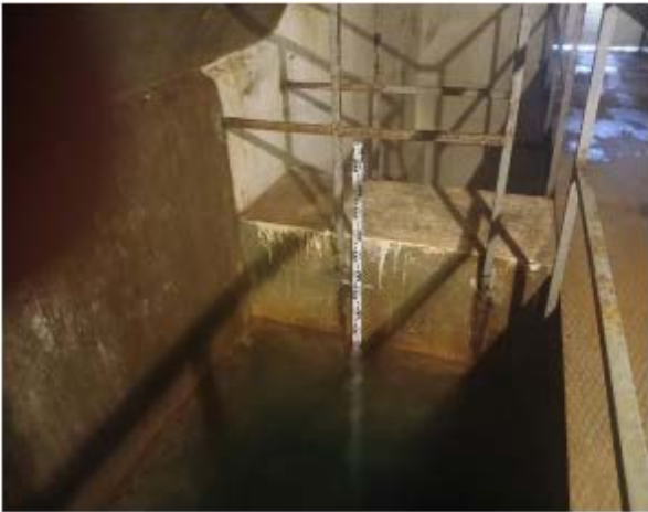
Slika 11 – Nivo letva u sabirnoj komori i Slika 12 - Odlaz vode LŽ cjevovodom DN 500
