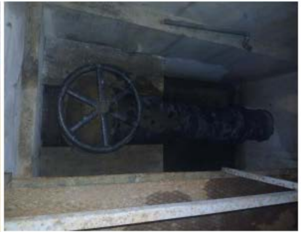
Slika 11 – Nivo letva u sabirnoj komori i Slika 12 - Odlaz vode LŽ cjevovodom DN 500
